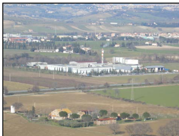
Foto 12 - Impianto di trattamento rifiuti (Cosmari)
