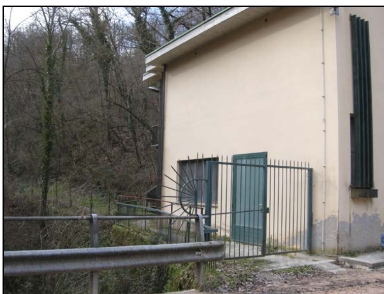
Foto 58 - Opera di captazione Sorgente Rofanello
