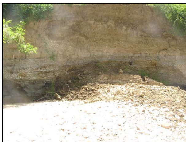
Foto 49 - Erosione laterale in corrispondenza di un tratto meandriforme del T. Fiastra
