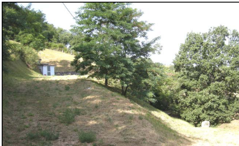
Foto 57 - Opere di captazione Sorgente Santa Lucia
