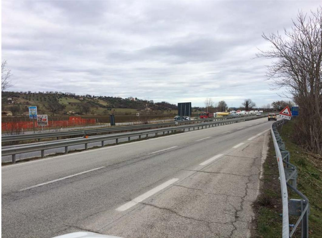
**Foto 5.4/5: Caratteristiche della piazzola di emergenza della Superstrada 77. La corsia di emergenza è assente.**
