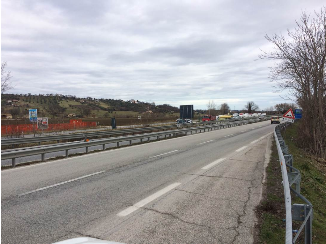
Foto 1.3/5: Caratteristiche della piazzola di emergenza della Superstrada 77. La corsia di emergenza è assente.
