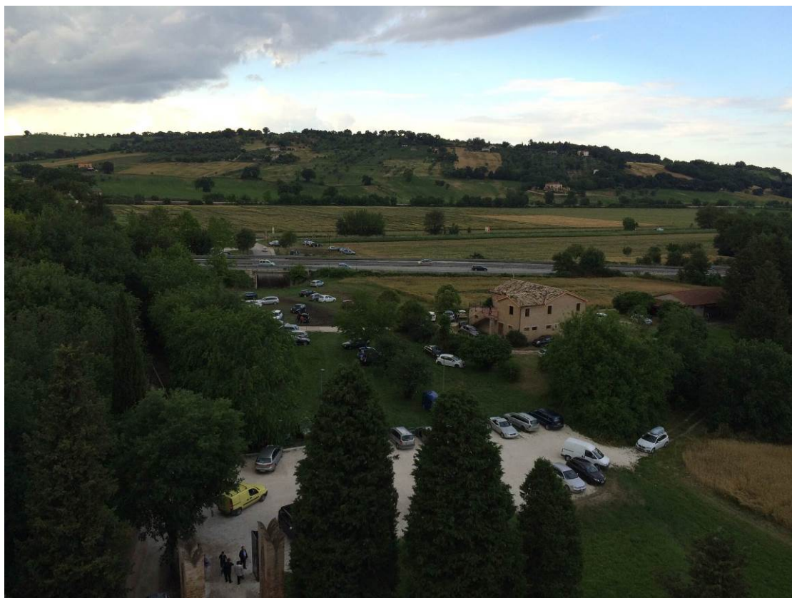
Foto 1.2.3/4: Vista del Varco fluviale dal Castello della Rancia
