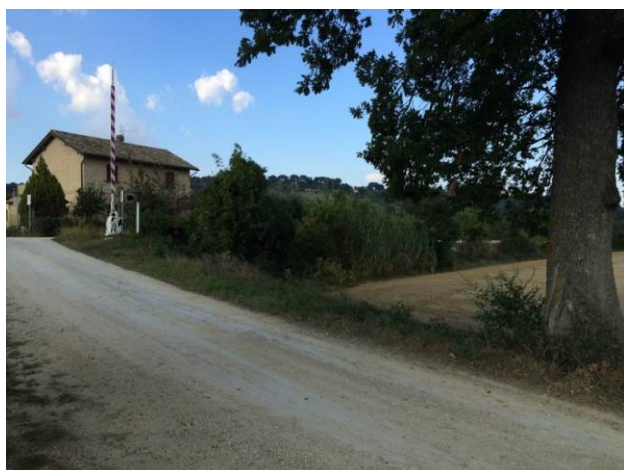
Foto 2.2/2: ex casello ferroviario
