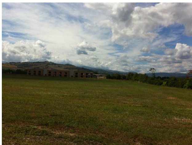
Foto 2.2/4: lato opposto della strada di accesso, a circa 260 m, si trova un centro commerciale in realizzazione
