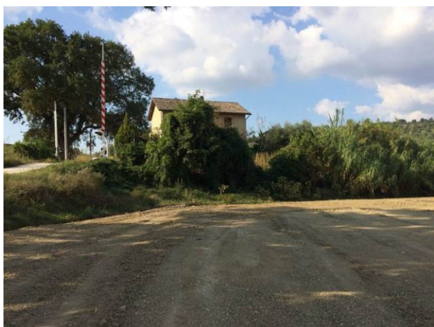
Foto 2.2/1: ex casello ferroviario
